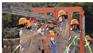
4号機を発射台に移す作業
